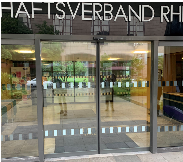
Abb. 4: Glassicherheitsmarkierung auf zwei Höhen zum Erkennen beim Blick nach vorne oder unten
